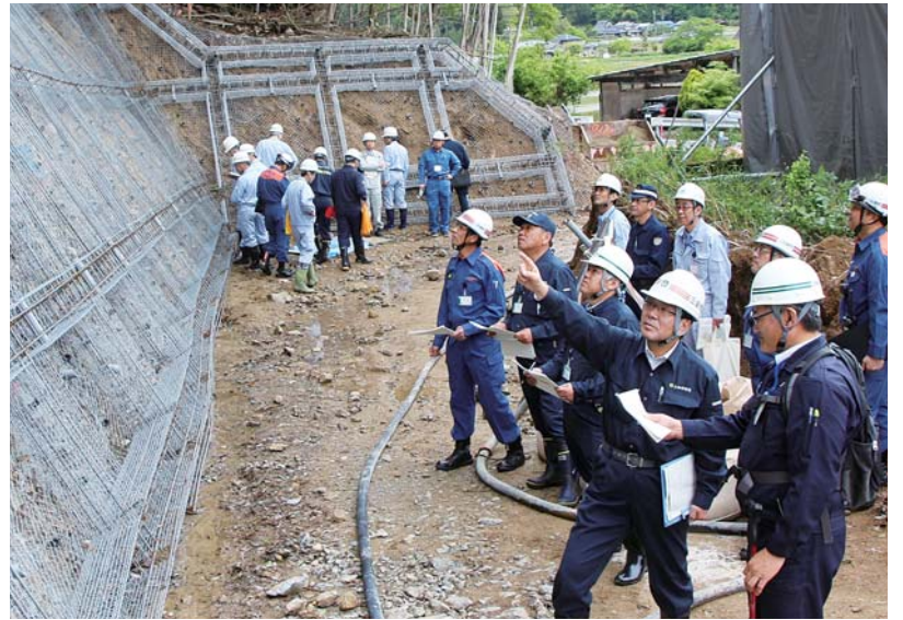
【5月11日に実施した水防・防災パトロールの様子＝小柿地区】
